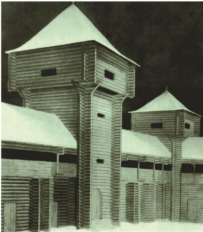
Фрагмент крепости. Вид изнутри
